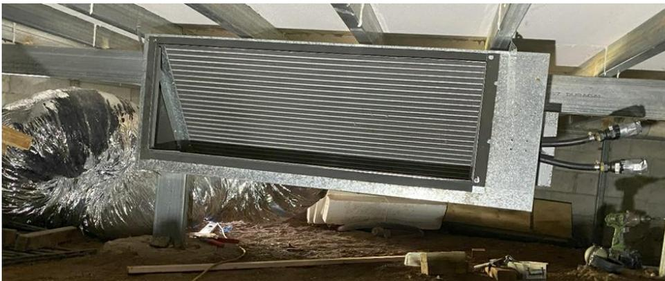
圖九: 水對空氣散熱器(空氣調節箱)。為了讓足夠的水流能通過散熱器，原本的供冷媒通過節流計量裝置管線被替換成更大的管道。
