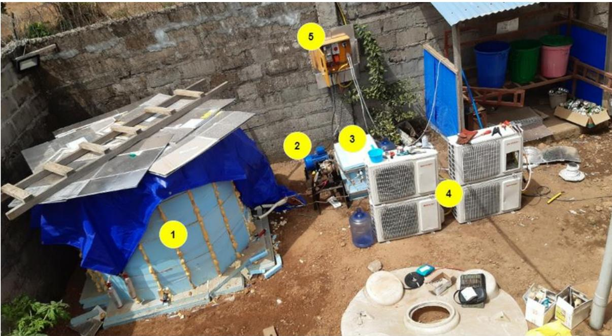
圖四: 4000 公升水槽, 安置在黃色變電箱裡的逆變器, 四台二手且已移除壓縮機的室外機
